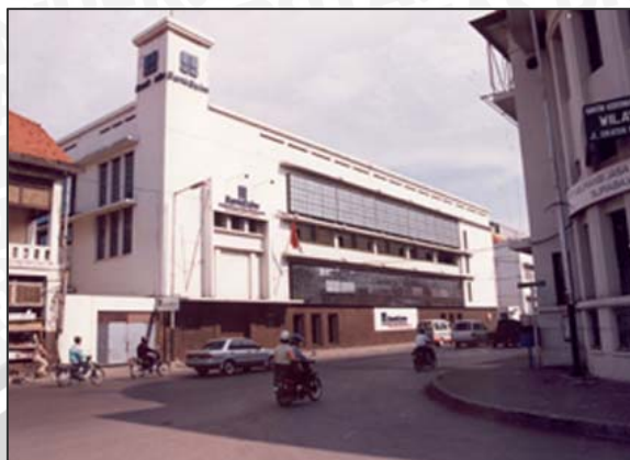
Gambar 5. 32 Tampilan Bank Mandiri/Gedung Borsumij Sumber : Survey primer, 2006
