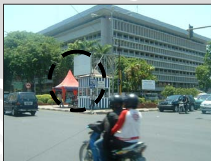
Gambar 4. 22 Kondisi pos parkir di Perempatan Kebonrojo
