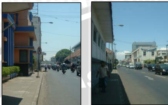
Gambar 4. 17 Kondisi Pedestrian Jalan Veteran sisi Timur (kiri) dan Barat (kanan)
