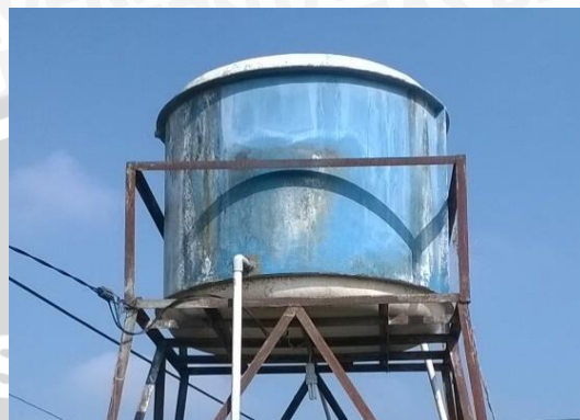
Bak Penampungan Air
