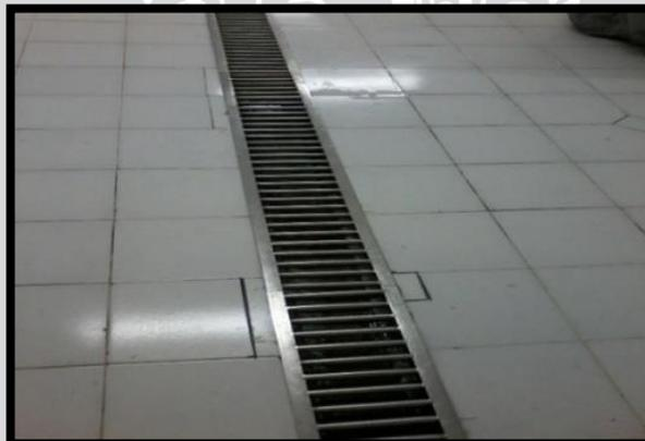
**Gambar 11. Saluran pembuangan limbah cair**
