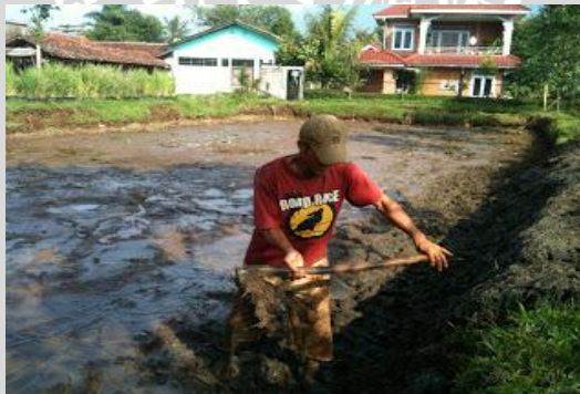
Gambar 29. Perbaikan konstruksi kolam
