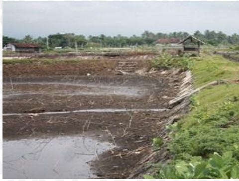
Gambar 28. Pengisian dasar kolam menggunakan tanah
