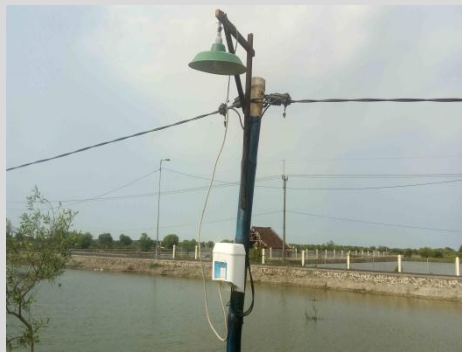
Gambar 26. Penerangan kolam menggunakan lampu
