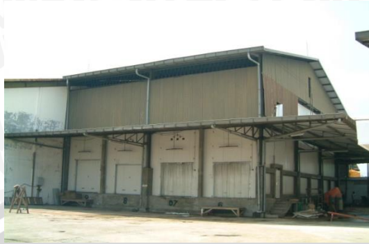
Gambar 5. Cold Storage Sumber: PT. Surya Alam Tunggal
