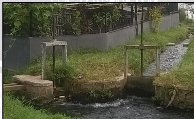
Gambar 2. Pintu pemasukan air ke IBAT Punten
