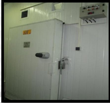
**Gambar 5. Mesin Pembekuan (Air Blast Freezer)**
