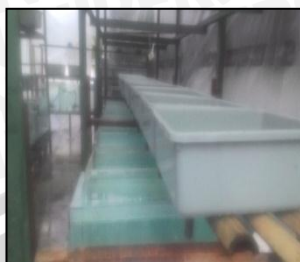
Pemasangan Unit Sistem
