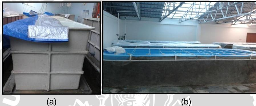
Gambar 23. Bak pemeliharaan larva (a) Bak fiber volume 500 Liter, (b) Bak beton volume 8 m<sup>3</sup> (Dokumentasi Pribadi, 2014)
