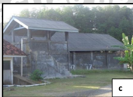
Gambar 9. Sistem Penyediaan Air Laut (a) Bak tandon air laut 200 ton, (b) sandfilter, (c) Bak tandon air laut 100 ton.
