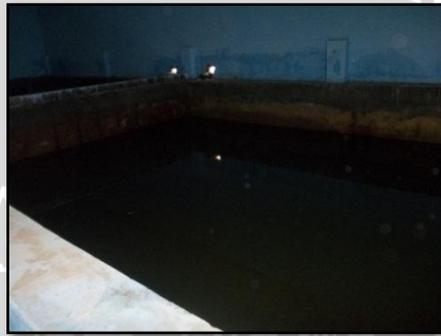
Gambar 15. Bak Pengendapan Air Laut
