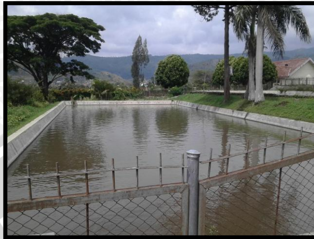
Gambar 6. Lokasi Stasiun 1 (Kolam Induk)
