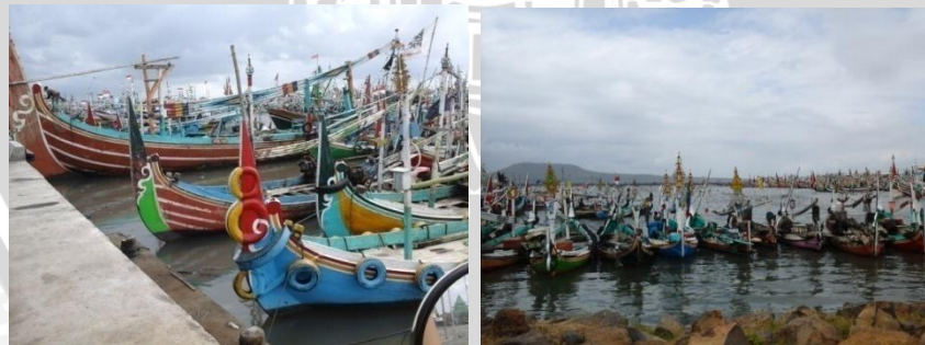
Gambar 28. Pelabuhan pendaratan ikan dan tambat labuh baru
