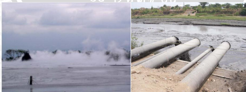
Gambar 1. Semburan Lumpur Lapindo (a) Pembuangan ke Sungai Porong (b)
