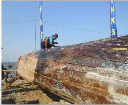
Gambar 18. Proses pelapisan resin
