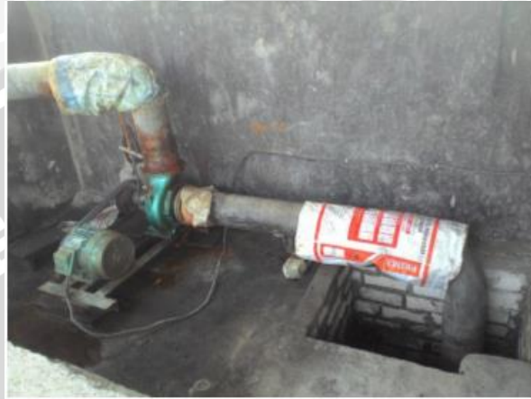
Gambar 05. Pompa sanyo berdiameter 10” untuk mengisi air tambak (Sumber: Data Praktek Kerja Magang, 2015)
