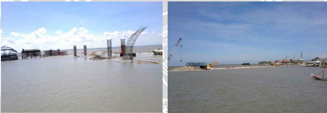
Gambar 19. Lokasi pembangunan jembatan baru.
