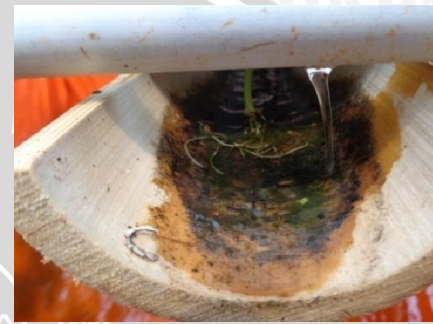
Saluran inlet air
