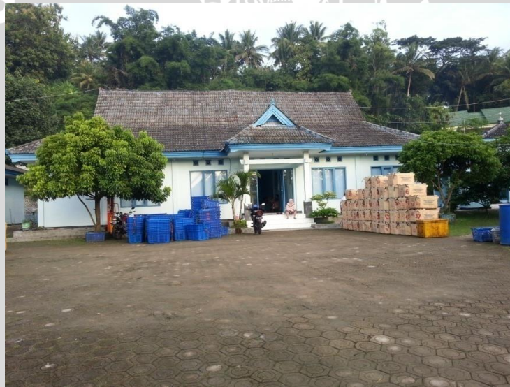
Gambar 10. Kantor Unit Pengelola Pelabuhan Perikanan Tamperan
