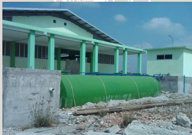
Gambar 13. Instalasi Pembuangan Air Limbah (IPAL).
