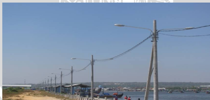
Gambar 19. Gardu dan jaringan listrik.
