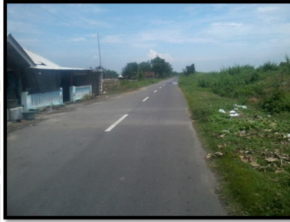
Gambar 7. Fasilitas Jalan Raya menuju Pulau Sarina
