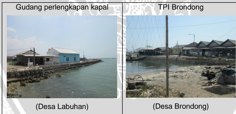
Gambar 7. Bangunan pantai di Desa Labuhan dan Desa Brondong
