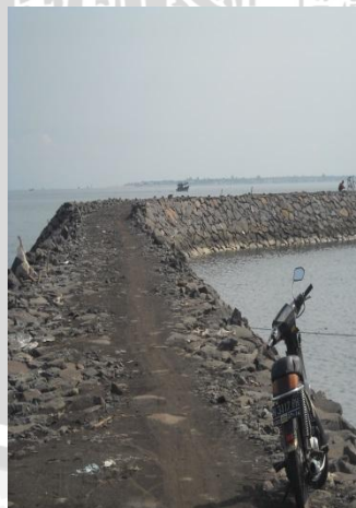
Breakwater sisi barat
