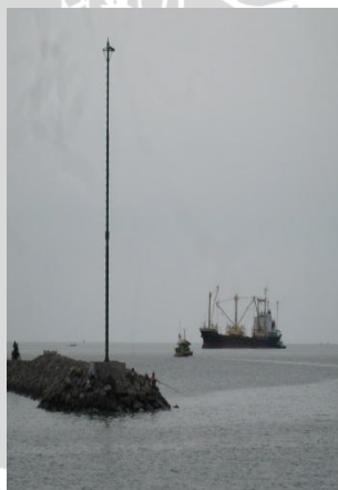
Lampu Penanda di Breakwater
