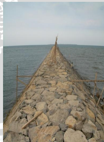
Breakwater sisi timur
