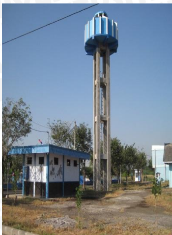
Stasiun Listrik dan Menara Air
