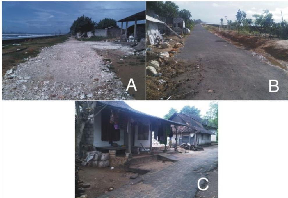
**Gambar 9.** Kondisi jalan yang ada di Desa Sobontoro, A) jalan makadam ; B) jalan aspal ; C) jalan paving
