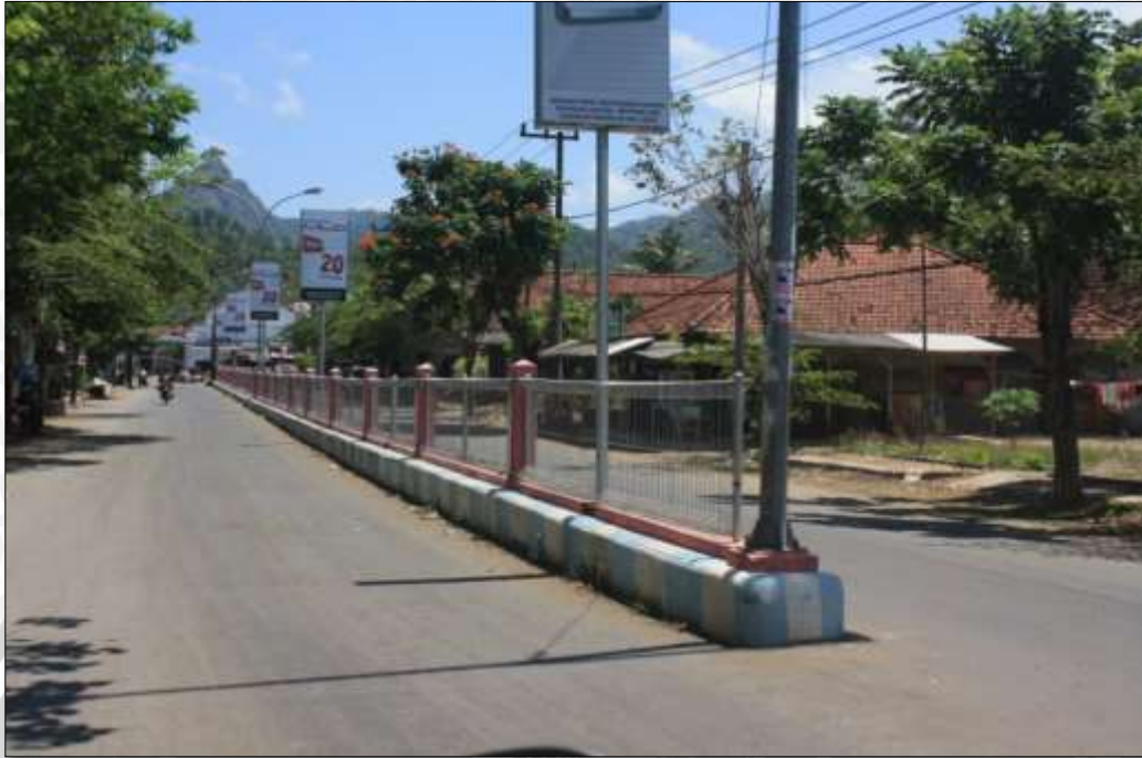
Fasilitas Umum Jalan Umum di Kecamatan Watulimo.
