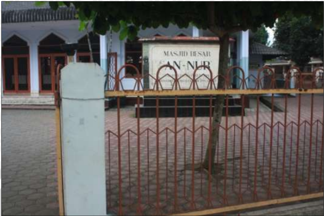
Fasilitas Peribadatan Masjid An-Nur Kecamatan Watulimo.
