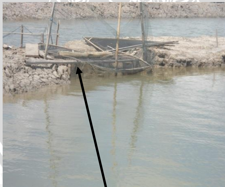
Gambar 4. Inlet (pintu masuk air)
