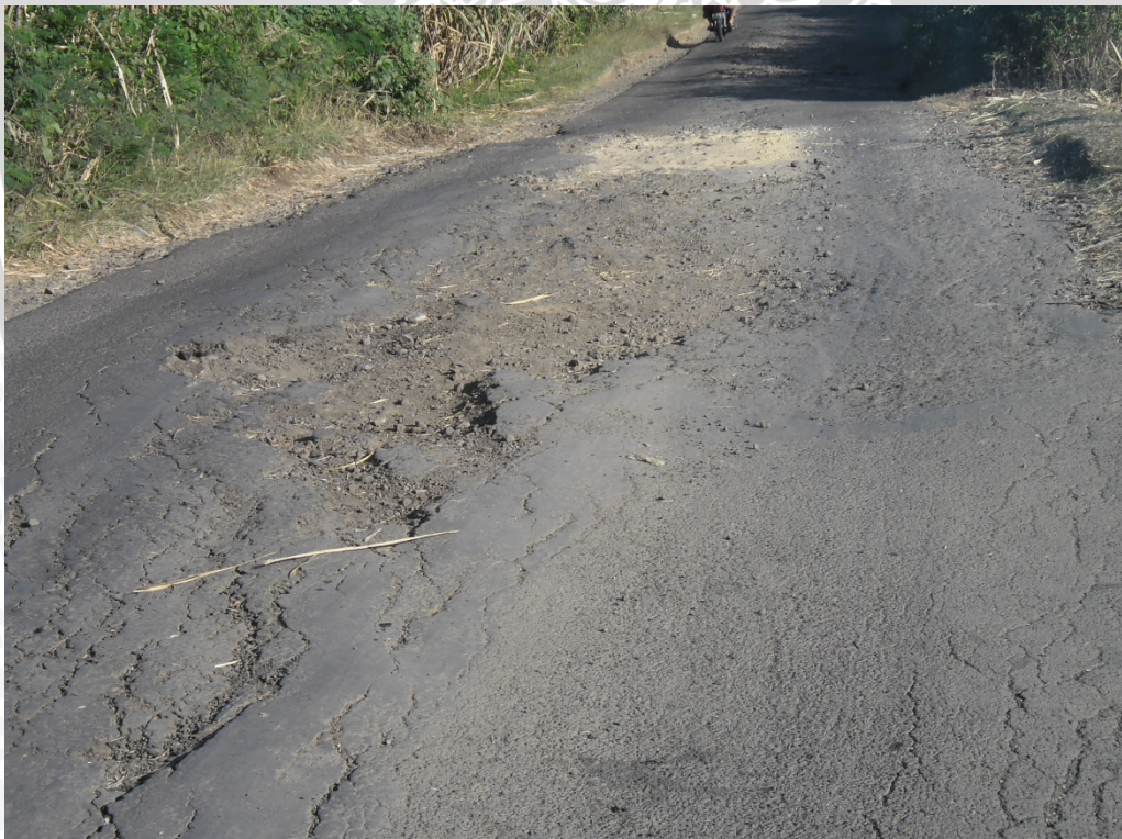
Gambar 22. Kondisi Jalan Menuju Pantai Balekambang
