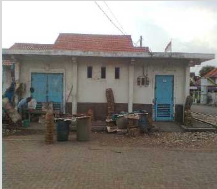
Gambar 16. Rumah Genset yang terdapat di BPPPI Puger
