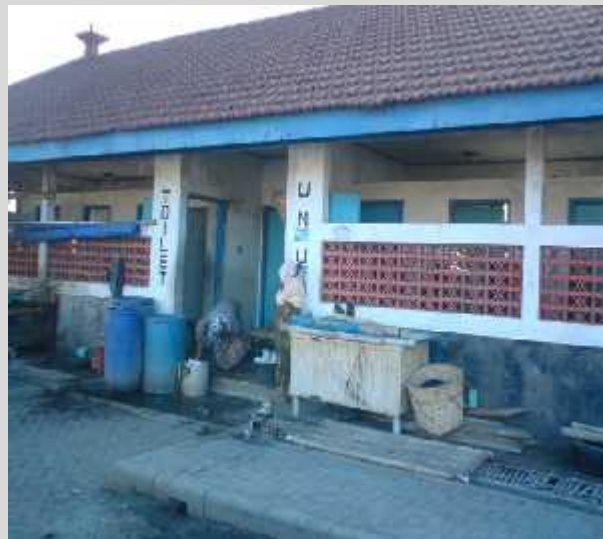
Gambar 12. Toilet/MCK I yang terdapat di BPPPI Puger
