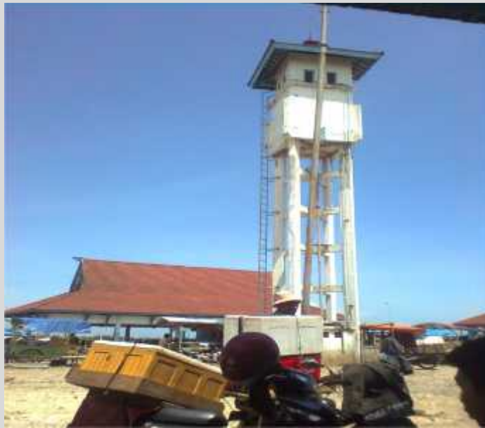
Gambar 11. Menara Air yang terdapat di BPPPI Puger
