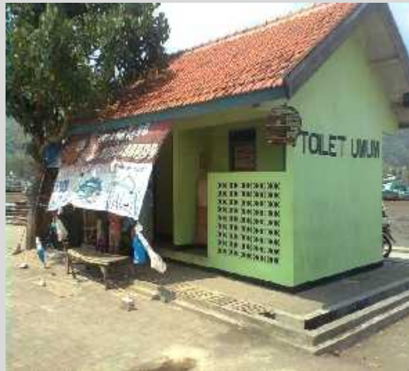
Gambar 13. Toilet/MCK II yang terdapat di BPPPI Puger
