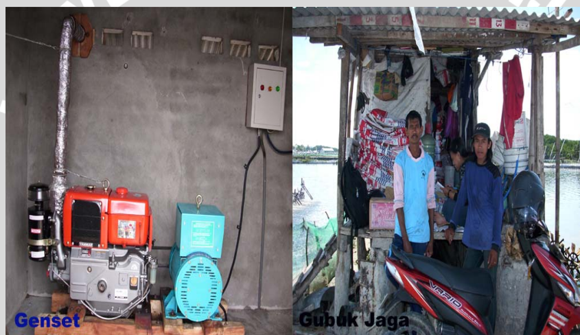
Gambar 8. Genset dan Gubuk Jaga
