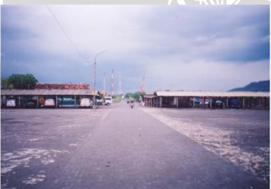
Gambar 7. Jalan Masuk TPI Depok
