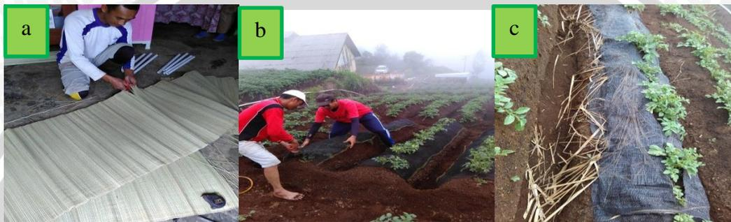
Gambar 2. Tahap pemasangan biogeotekstil (a) Pemotongan dan pelubangan bahan geotekstil, (b) Pemasangan geotekstil, dan (c) Penambahan mulsa organik diantara bahan geotekstil (Foto: Nhindyasari, 2016)
