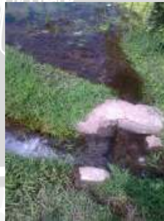
Temuku sebagai Bangunan Pembagi Air Sumber: Ningrum, 2012
