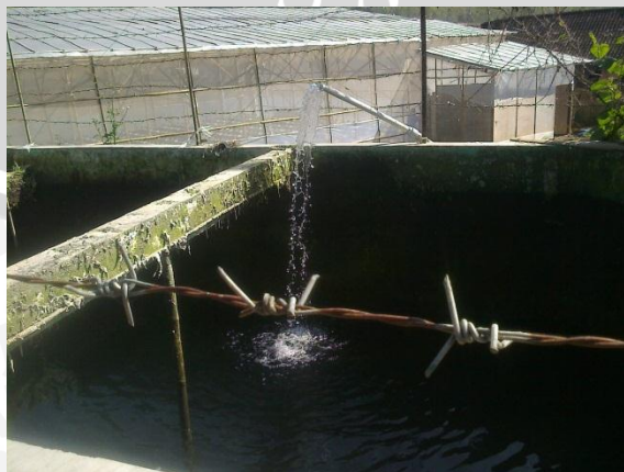
Gambar 11. Tempat penampungan Air Irigasi
