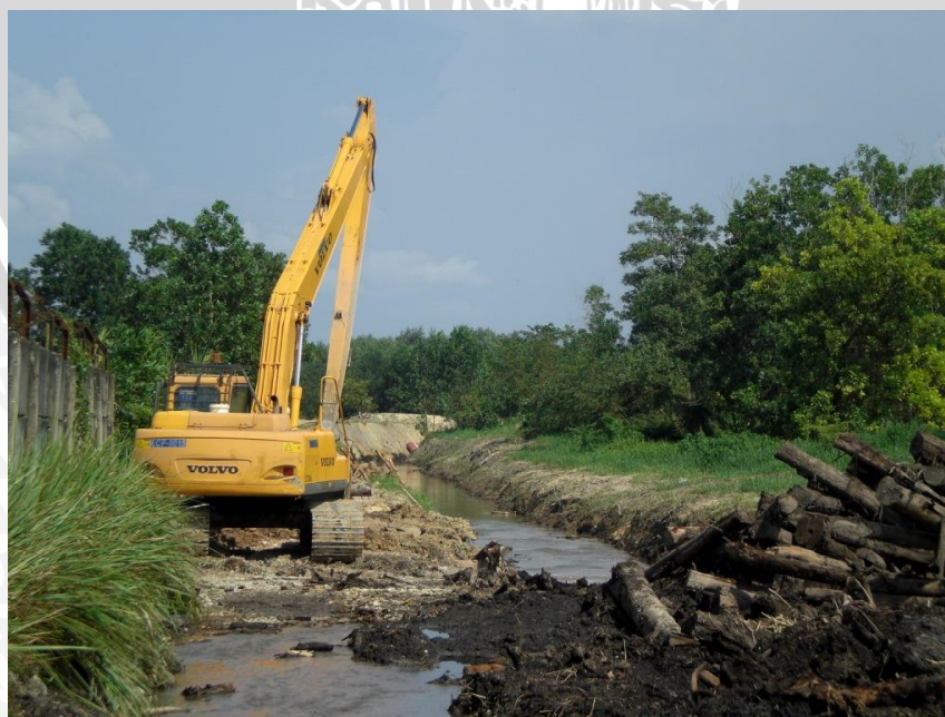
Proses land-clearing dan pembuatan saluran air dengan alat berat
