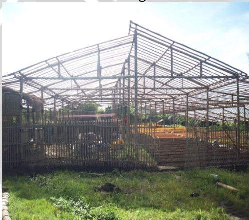
Greenhouse baru di bangun
