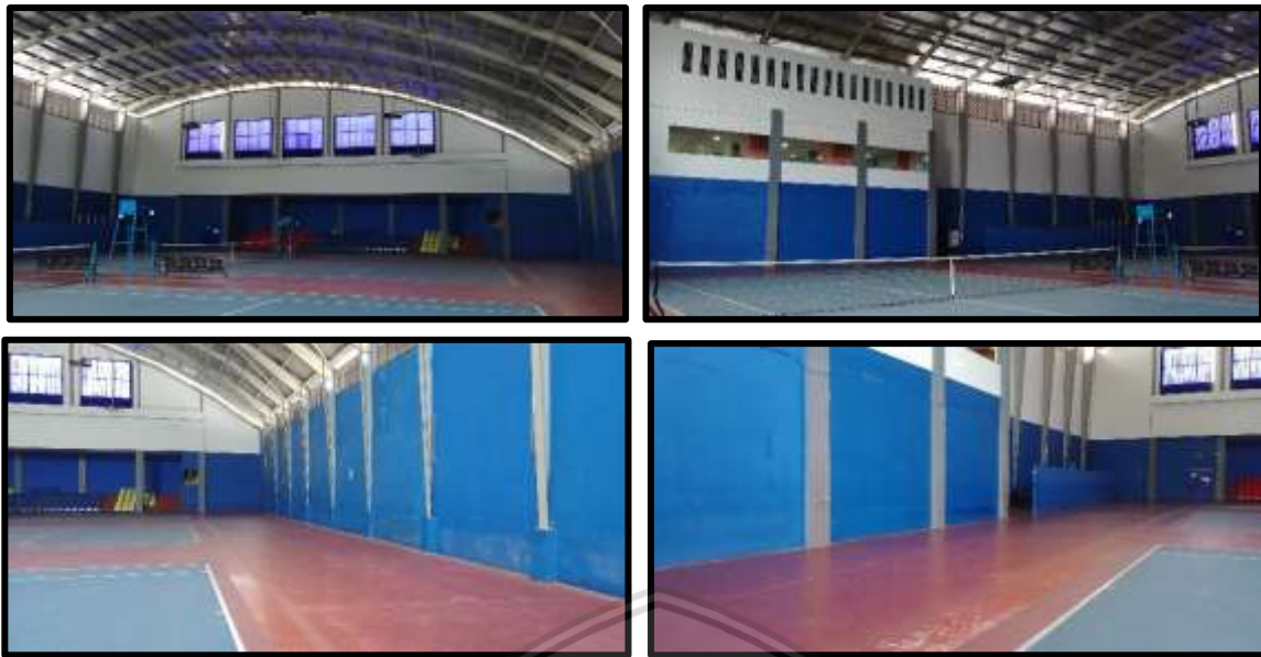
Gambar 4. 76 Foto Eksisting Kondisi Permukaan Bidang Dinding
