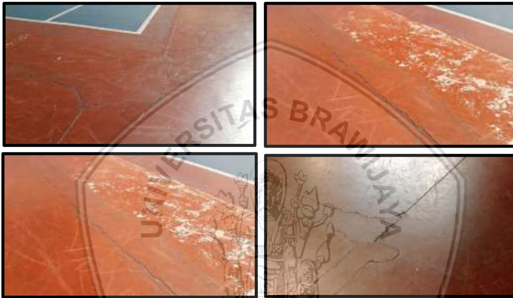
Gambar 4. 77 Foto Kondisi Eksisting Permukaan Lantai Lapangan Tenis Indoor
