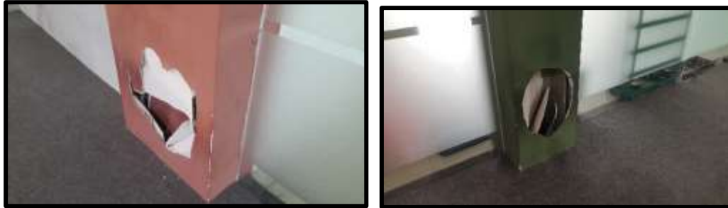
Gambar 4. 27 Foto Eksisting Dinding Gypsum
