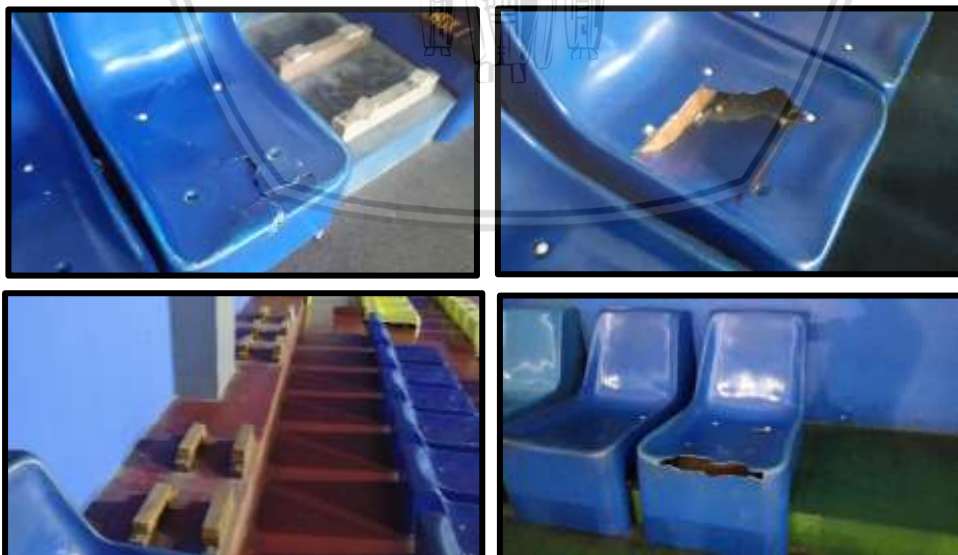
Gambar 4. 83 Titik Kursi Tribun yang Mengalami Kerusakan
