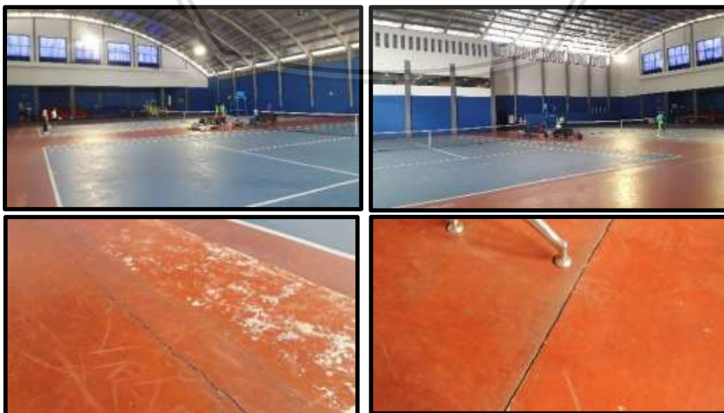
Gambar 4. 54 Foto Eksisting Lantai Hard Court Lapangan Tenis Indoor
