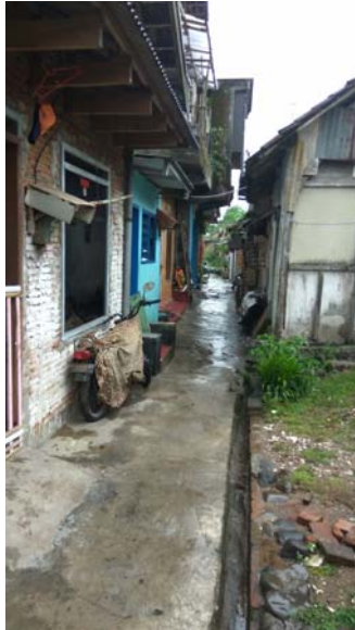
Gambar 4. 11 Kondisi Drainase RW 08
