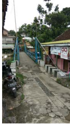
Gambar 4. 12 Kondisi Jalan Lingkungan yang Rusak
