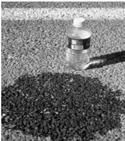
Gambar 2.8 Infiltrasi pada permukaan beton porous di tempat parkir akuarium florida di Tampa, Florida (Sumber: Ferguson, 2005)
