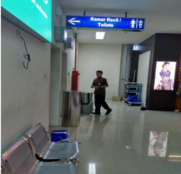
Gambar 4.9 Kondisi papan petunjuk fasilitas toilet Sumber: Dokumentasi Bandar Udara Abdulrachman Saleh
