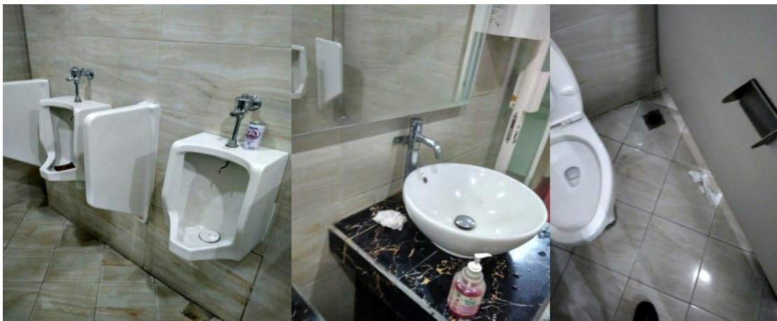
Gambar 4.15 Kondisi toilet di lantai 2
