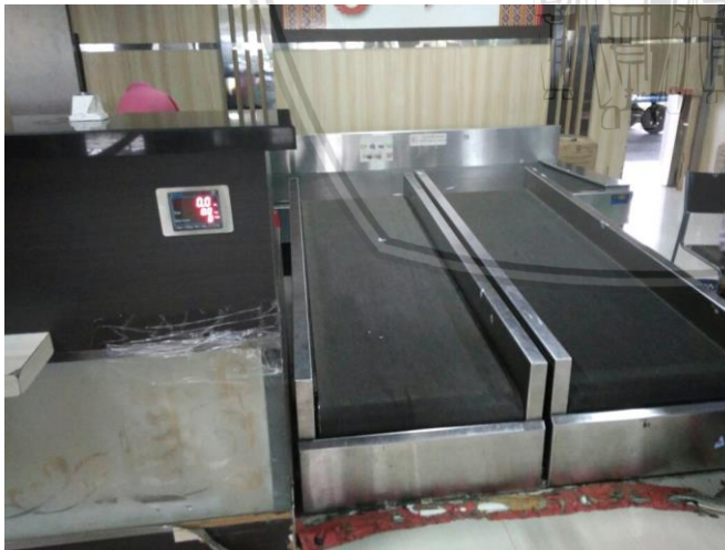
Gambar 4.19 Kondisi konter bagasi
