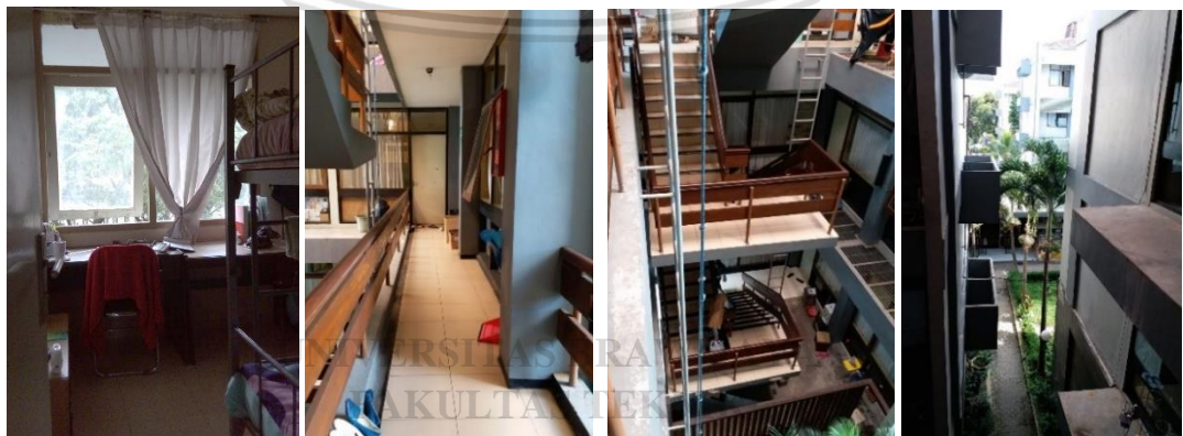
Gambar 4.19 Kondisi Gedung A Asrama Griya Brawijaya
