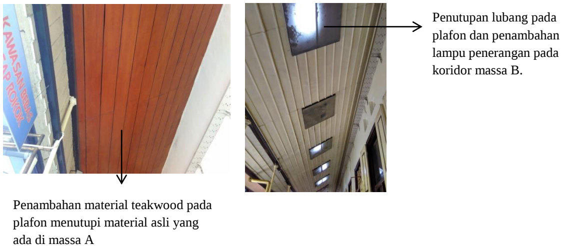
Gambar 4.112 Perubahan pada Plafon
