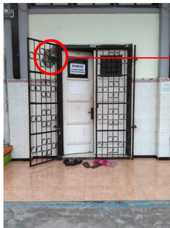
Dinding mengelupas pada massa C
