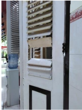
Krepyak pintu pada massa A mengalami kerusakan akibat usia yang sudah tua.
