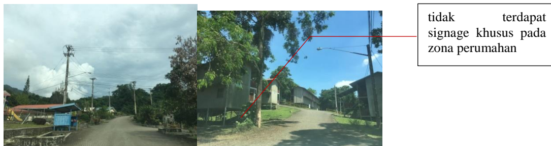
Gambar 4. 37 Signage eksisting zona perumahan
