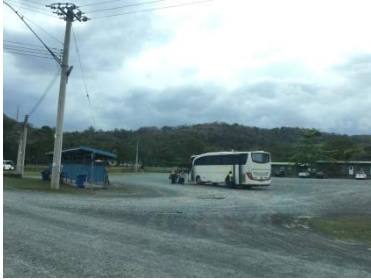
Gambar 4. 18 Kondisi eksisting penghubung zona sarana & fasilitas umum
