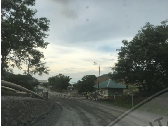
Gambar 4. 3 Security gate menuju kawasan
