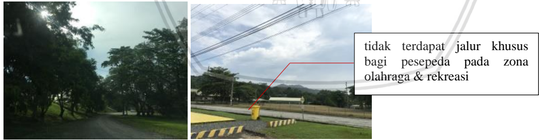
Gambar 4. 75 Kondisi eksisting jalur pesepeda zona olahraga & rekreasi
