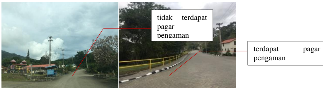
Gambar 4. 49 Kondisi eksisting pagar pengaman zona perumahan Keamanan pejalan kaki diwujudkan dengan adanya pagar pengaman pada area pejalan kaki. Namun pada Pada eksisting terlihat tidak terdapat pagar pengaman khusus pada zona perdangan dan perkantoran.
