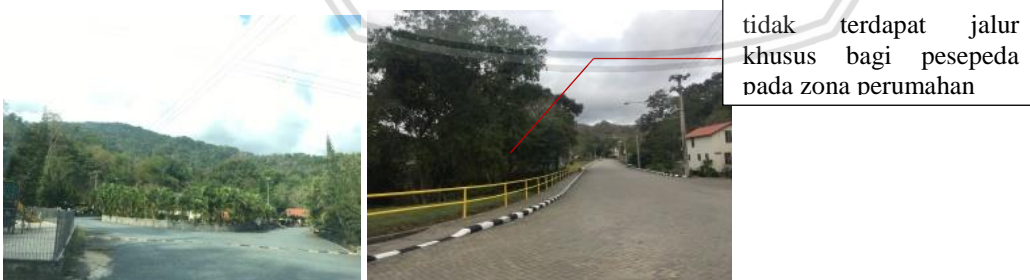
Gambar 4. 72 Kondisi eksisting jalur pesepeda zona perumahan
