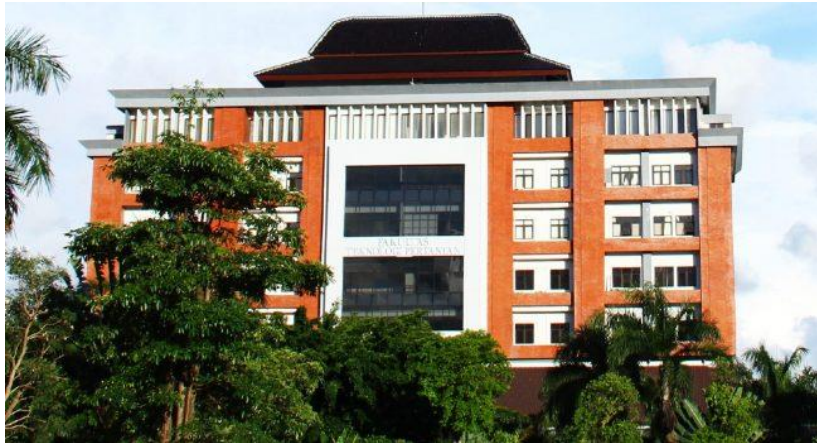
Gambar 4.20 Shading device berupa sirip vertikal pada lantai 8 Sumber: tp.ub.ac.id
