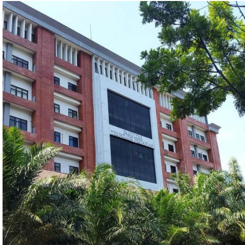
Gambar 4.22 Self-shading pada beberapa bagian dan sisi kaca tanpa shading device Sumber: www.pictame.com
