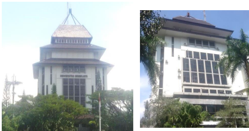
Gambar 4.93 Sisi utara Gedung Rektorat (kanan) yang memiliki area kaca yang luas dan area kaca sisi barat Gedung Rektorat (kiri) terbayangi sosoran atap
