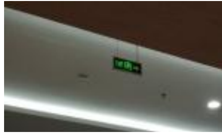
Gambar 4.76 Signage Menuju Pintu Darurat B4 di Depan tenant Matahari
