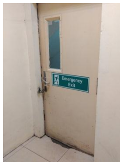
Gambar 4.19 Pintu Darurat Lantai 2 (pintu B2)
