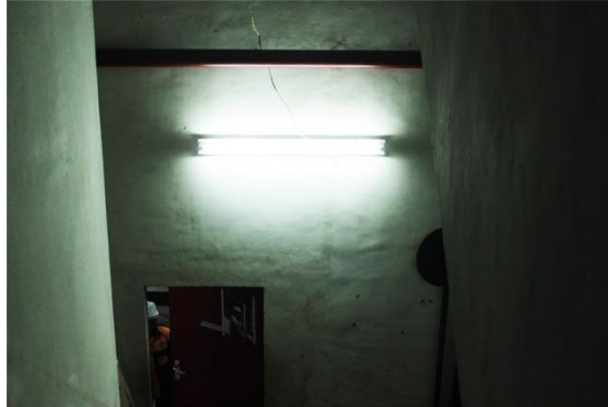
Gambar 4.96 Pencahayaan dalam ruang eksit terlindung
