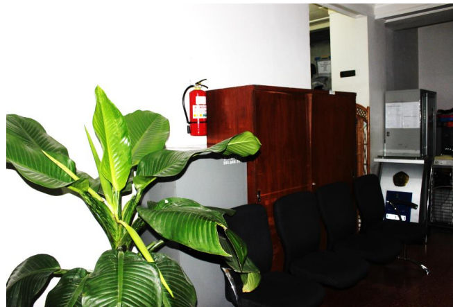
Gambar 4.111 Tabung APAR lantai 5 terhalang oleh perabot
