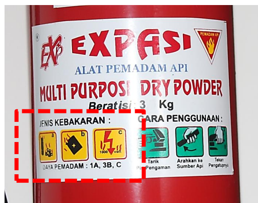
Gambar 4.107 APAR tipe 1A, 3B, C pada bangunan eksisting
