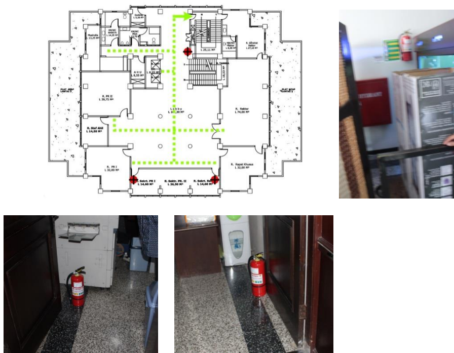
Gambar 4.113 Penempatan APAR lantai 7 yang tersembunyi
