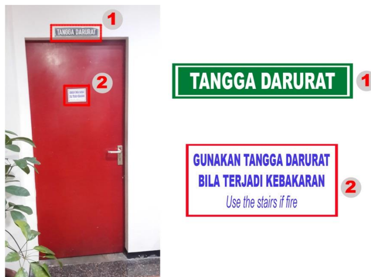
Gambar 4.84 Signage pada pintu eksit terlindung
