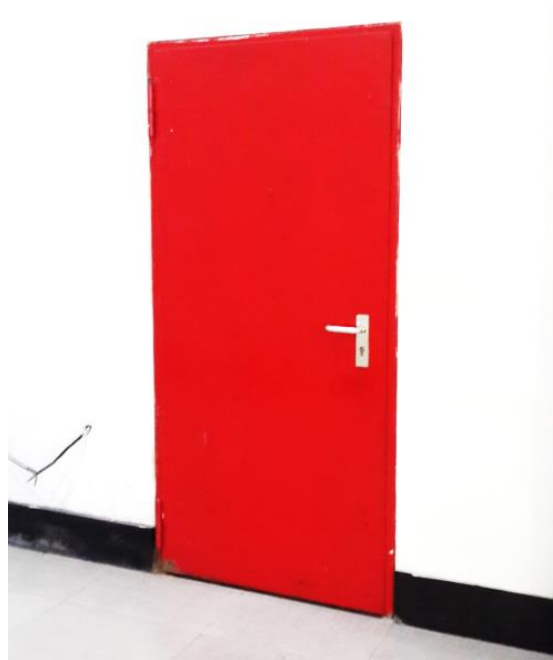
Gambar 4.83 Warna pintu ruang eksit terlindung
