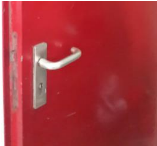
Gambar 4.81 Pengunci pintu eksit terlindung Gedung Rektorat
