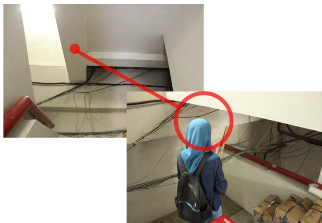
Gambar 4.91 Tonjolan balok lantai pada bordes tangga darurat
