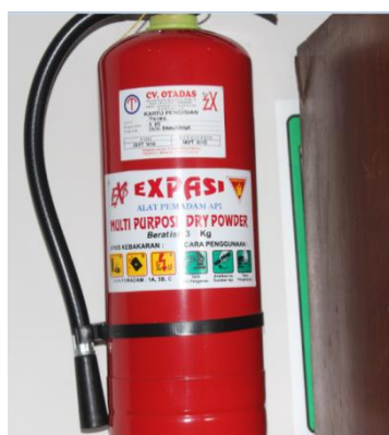
Instruksi penggunaan APAR yang tertutup
