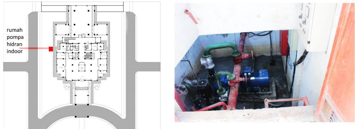
Gambar 4.115 Pompa hidran indoor
