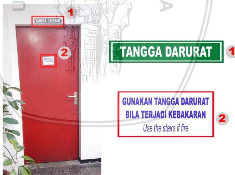
Gambar 4.84 Signage pada pintu eksit terlindung
