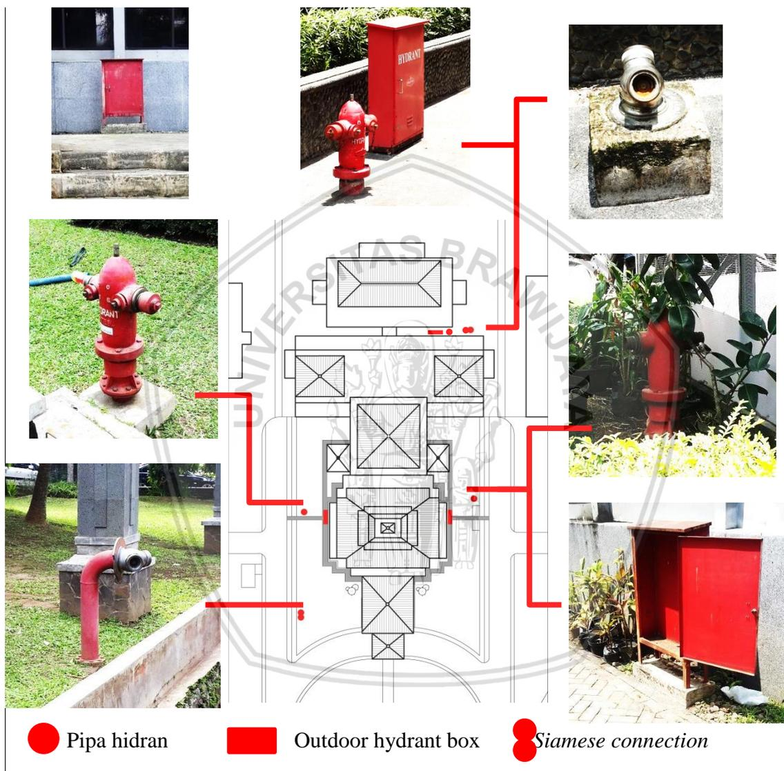
Gambar 4.29 Letak hidran halaman gedung rektorat UB
