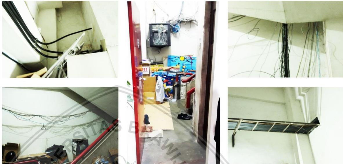
Gambar 4.89 Sistem utilitas pada ruang eksit terlindung
