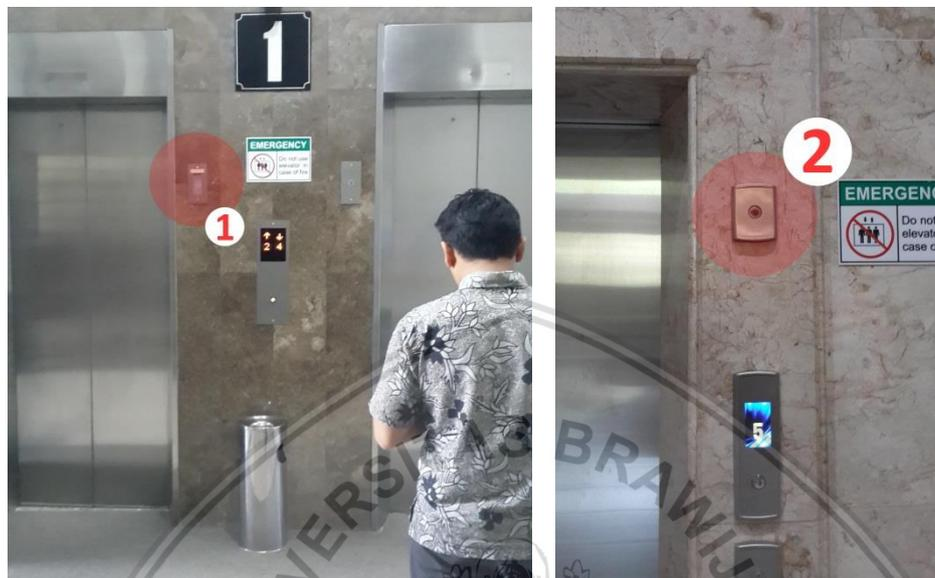
Gambar 4.104 MCP pada area lift
