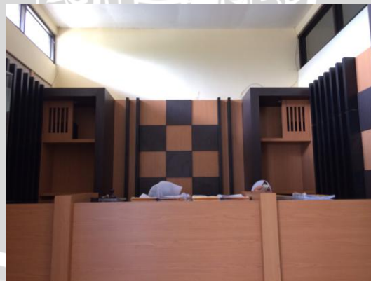
Gambar 3. Bilik Pelayanan Yang di Renovasi
