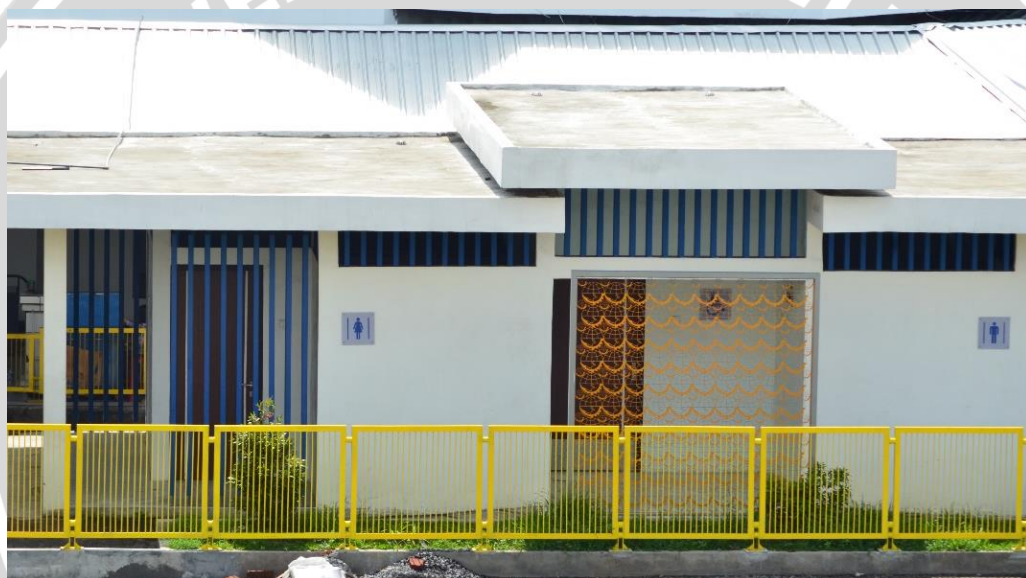
Gambar 15. Toilet Baru Pada Saat Belum Digunakan Sumber : Dokumentasi Peneliti, 2016
