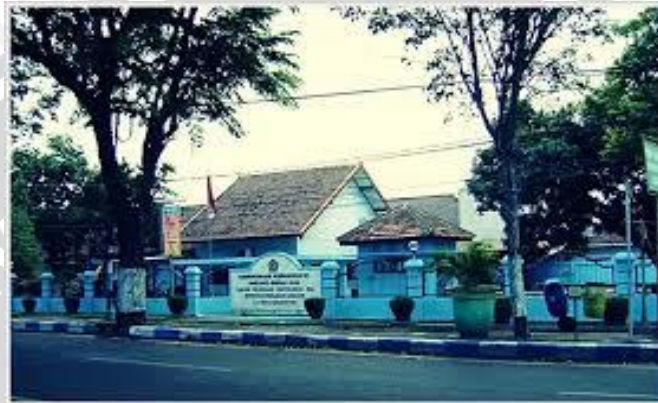
Gambar 4.1 Bangunan KP2KP Lumajang (Sumber : KP2KP Lumajang, 2016)
